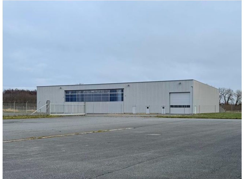
Freistehender Hangar (Bauteil 8)
